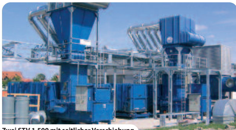
Zwei STV 1.500 mit seitlicher Verschiebung unterhalb von Absauganlagen installiert
